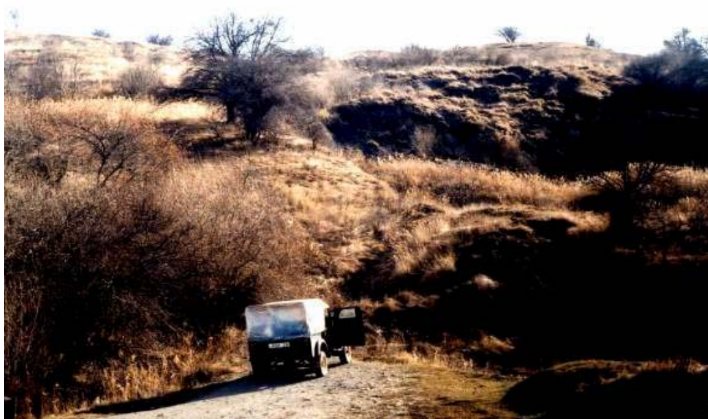
Рис. 2. Снесенные оползнем 0,7 км дороги на перевале Гомбори. (фото М. Гонгадзе)
